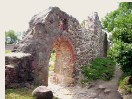
Dobeles pils vārti. Foto: T. Baranauskas
